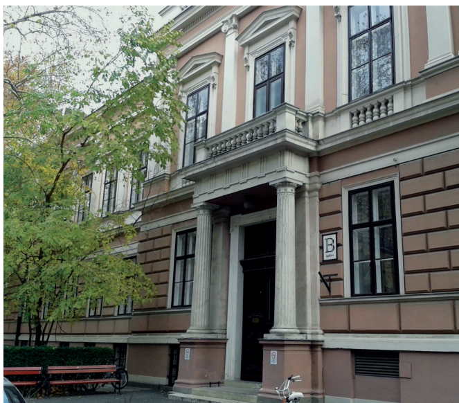
3. ábra. A Than-féle Trefort kerti B épület
