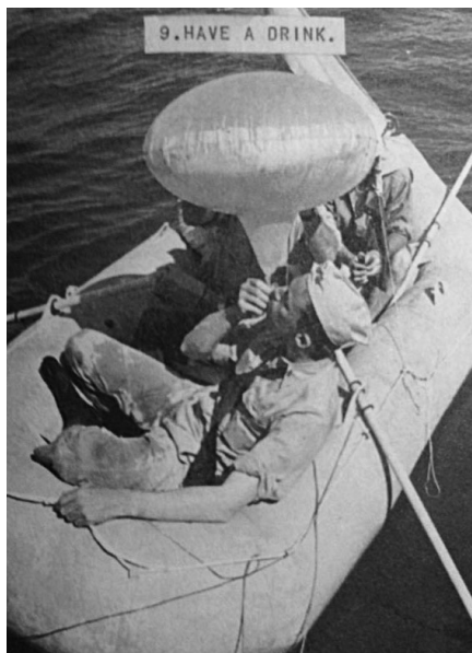
5. ábra. Egy katona iszik a Telkes-féle lepárlókészülékből
