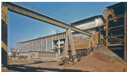
TVM I. SZ. KÉNSAVGYÁR ÉPÍTÉSE
