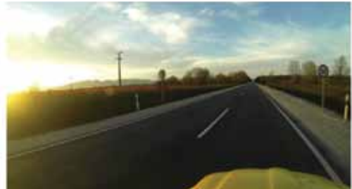
18. ábra: 1+1 sávossal kialakított szakasz (normál kétsávossal), előzés megengedett, sebesség 90 km/h
