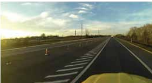
19. ábra: Forgalom elől elzárt terület, flexibilis függőleges jelzöttest
