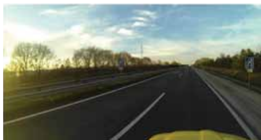
21. ábra: Sávelfogyás előjelzése
