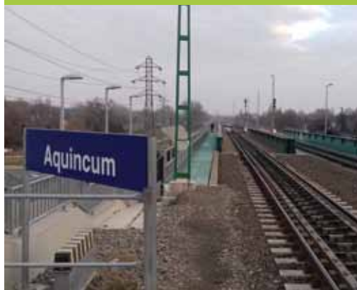
4. ábra: Szolgálati átjáró és gyalogoshíd a vasúti hídon
