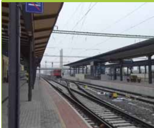
8. ábra: Vágánykapcsolat a peron mellett. Békéscsabán megoldották, amit Vácon nem tudtak
