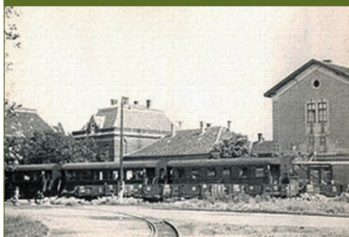
4. ábra: A felvételi épület város felőli oldala [5]
