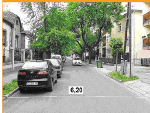
2. ábra: A 6 m körüli útszélesség problémái
