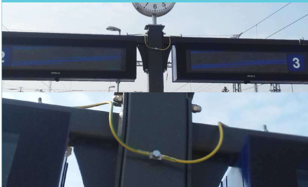
1. ábra: Felületes földelések Pécel állomás peronkijelzőjén
