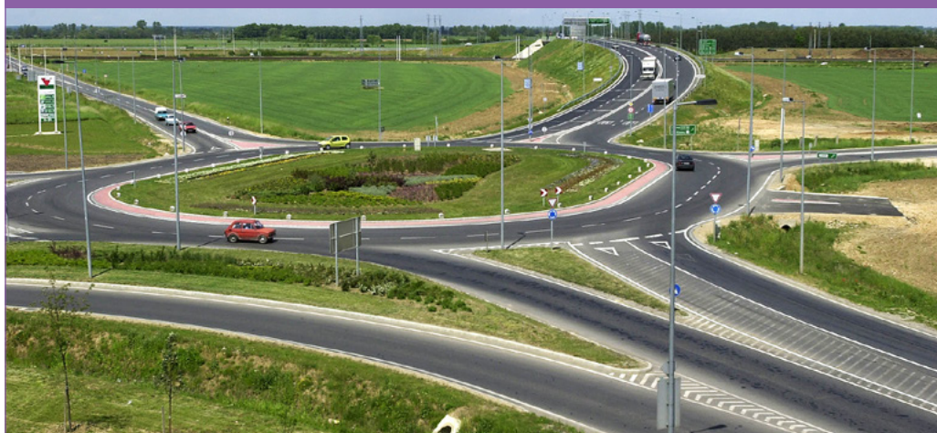
7. ábra: Ilyen lett: A hétágú Szombathely, Zanati úti körforgalom a 86. számú Zanat elkerülő út megépítése után
