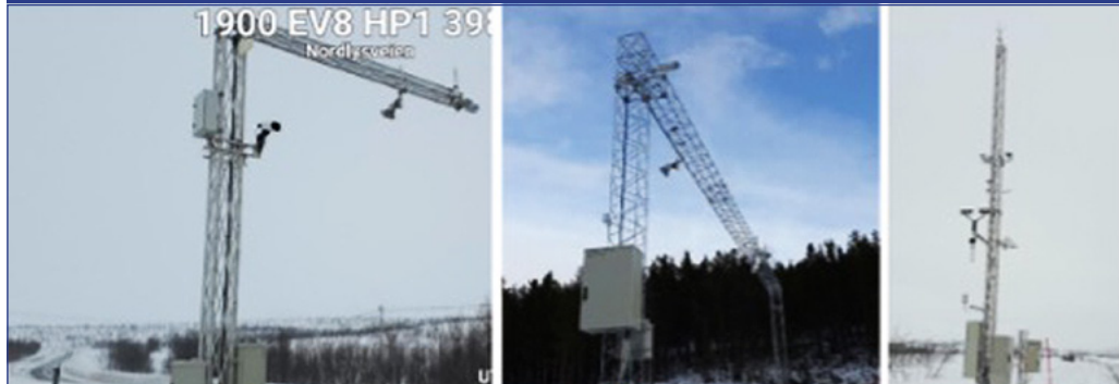
2. ábra: A NordicWay projektben alkalmazott szenzortartó szerkezetek [3]
