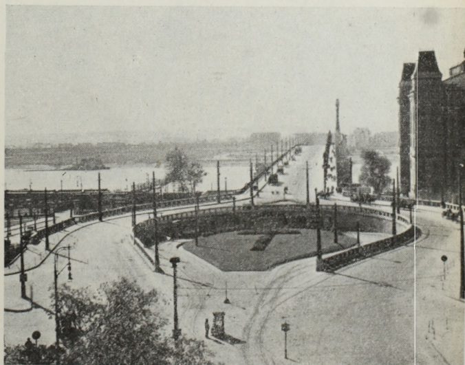
2. kép. A Boráros-téri híd pesti hídfeljárója
