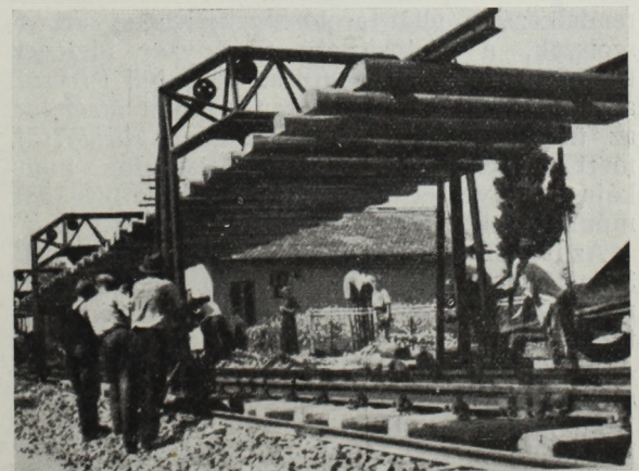
10. ábra. Rakománnyal leemelt 36 m-es vágánymező továbbítása a fektetéshez 3 daruvál
