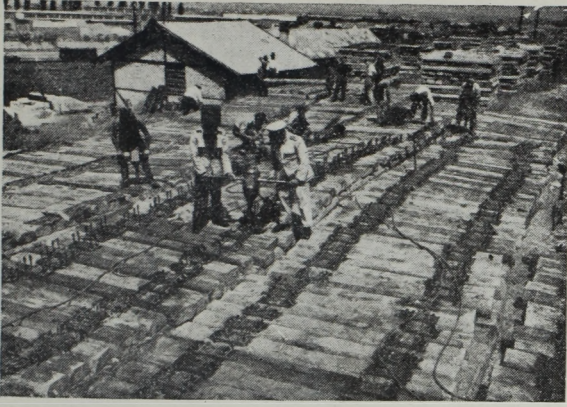
12. Alátétlemezek felszerelése a talpfákra.
