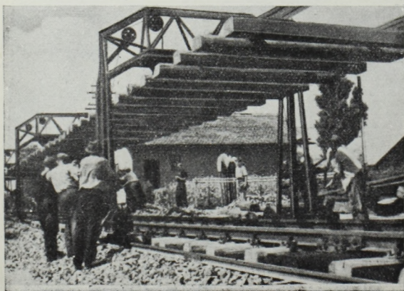
19. Sínmező kitolása a helyszínre portáldaruk és munkavágány segítségével.
