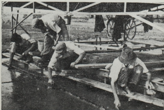
6. Betonburkolat keresztirányú hézagának készítése védősátor alatt.
