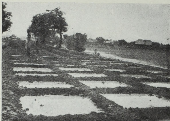
7. Földkazetták között elárasztott betonburkolat.
