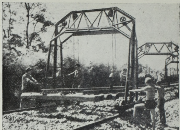
20. Sínmező leengedése a végleges beépítési helyre portáldaru segítségével.
