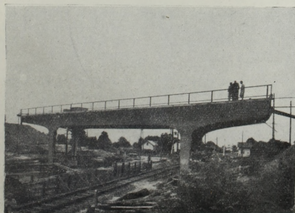
35. Konzolos, kétsuklós kerethíd építés közben. A közúti felüljáró hidfői még hiányoznak.
