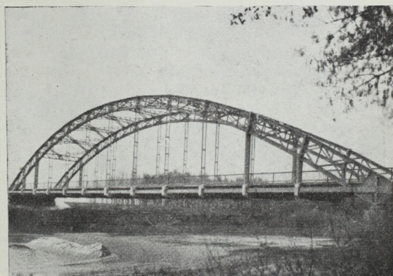
37. Vonógerendás, rácsos ívhíd.
