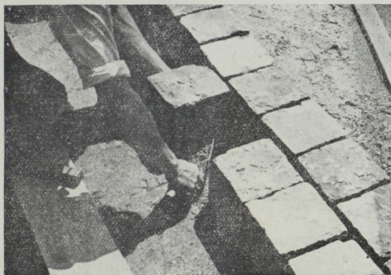
2. Nagykockakő burkolat fektetése.
