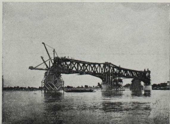
27. Rácsos acélhid széles folyó felett, szabadon, állványozás nélkül szerelve.
