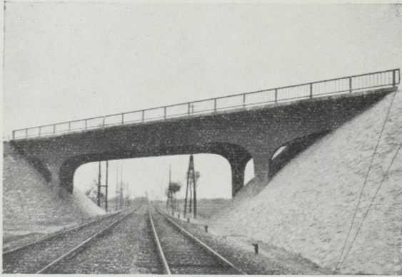
40. Konzolos, kétsuklós, ferde kerethíd, betonbarakott terméskőkúp lezárással.
