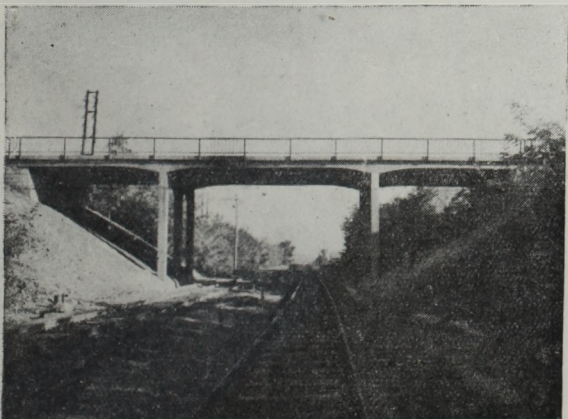
24. Útfelüljáró vb. hid. Konzolos, kétsuklós keret földkúp lezárással.
