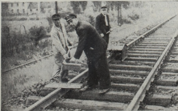
13. ábra. A zúzalékanyag kimérése.
