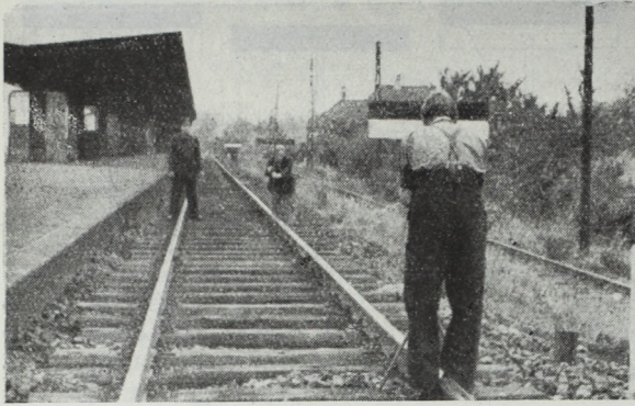
6. ábra. A látható süppedések mérése irányzóábrás berendezéssel.
