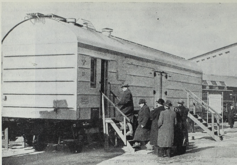
2. ábra. Gépesített hűtőkocsi
