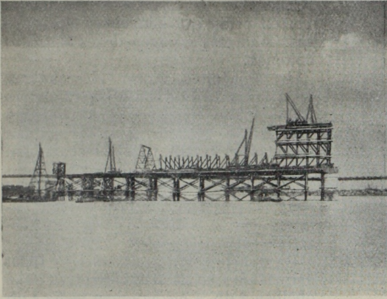
10. ábra. A középső, állványon szerelt hídszerkezet.
