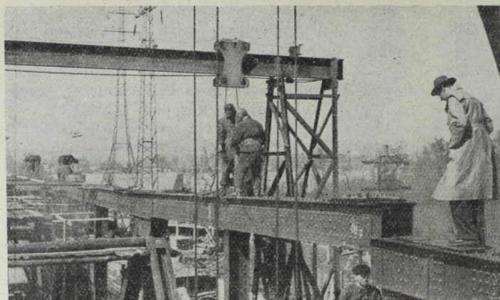
13. ábra. A kikötői öbölhid két részének találkozása.
