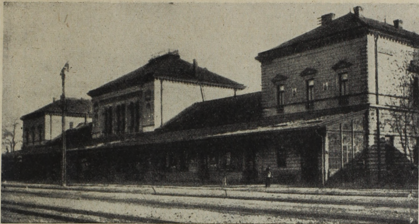
16. ábra. A füzesabonyi felvételi épület. A MÁV által a kilencvenes évek elején épített, nemes, szép és nyugodt architektúrát mutató felvételi épülete
