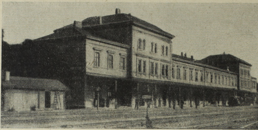
15. ábra. Reprezentatív megjelenésű felvételi épület: az államvasutak által épített Zimony állomás A 80-as évek építészete, a szokásostól eltérő tömegalkotással
