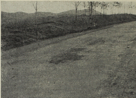
2. ábra. Télvégi útburkolat-romlás bevágásban levő útszakaszokon
