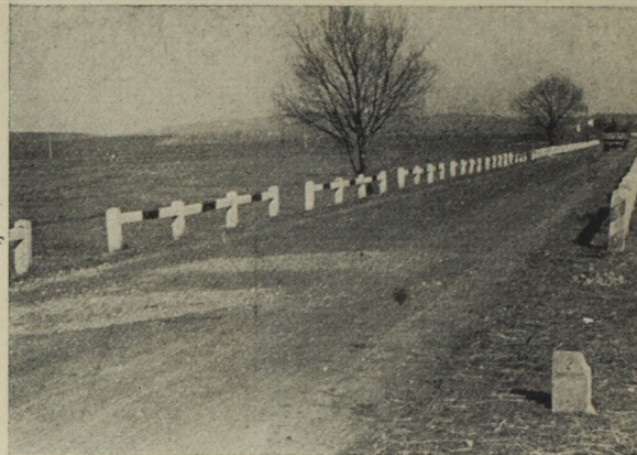
3. ábra. Télvégi útburkolat-romlás töltésen levő útszakaszon
