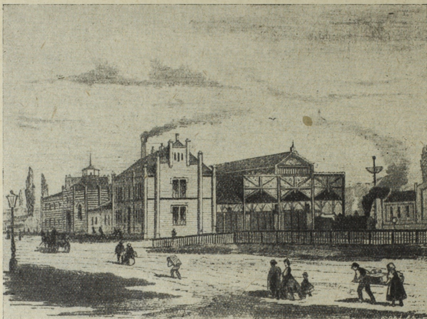
3. ábra. A Tiszavidéki Vasút Kassa állomása (1860). A romantikus stílusban épített felvételi épület előtt faacsarnok fedi a vágányokat
