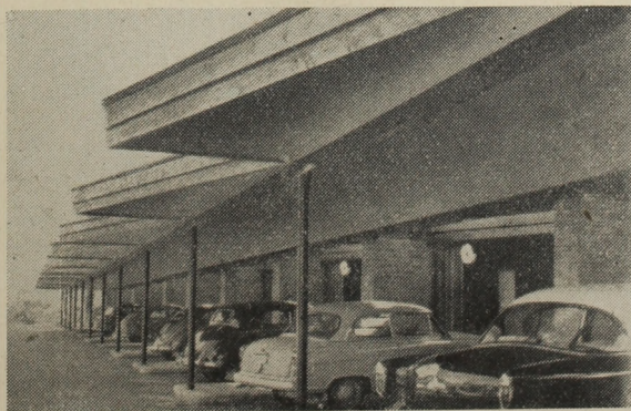
9. ábra. Motel Gyllene Raten, gépkocsi-parkolója. (Bauen + Wohnen, 1957., 7., 228. old.)
