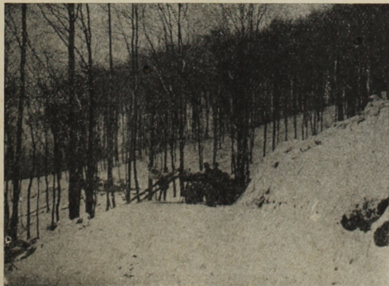
1. ábra. Vágástéri feltáróút a Pilisi Erdőgazdaságban: doserrel kialakított bevágási szakasz (csőrőlős fatelrakás)
