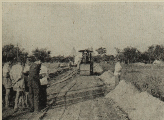
10. ábra. Mechanikai stabilizáció építése a Kismarja-hencidai összekötő úton
