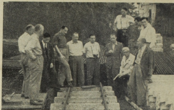
3. ábra. Kísvasúti vasbetonaljak előre lekötött sínmezőben a tárolótelepen. A tanulmányi kirándulás résztvevőinek egy csoportja
