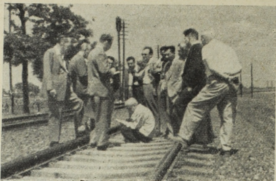
2. ábra. Az értekezlet résztvevői a rugalmas sínleerősítésű előfeszített vasbetonaljakat tanulmányozzák az egyik fővonalai kísérleti szakaszon
