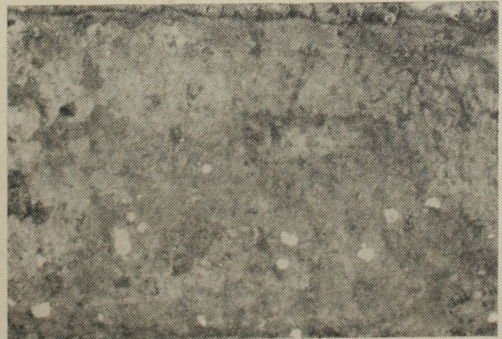
I. ábra. Szerkocsi oldalfalrész korrodálása
