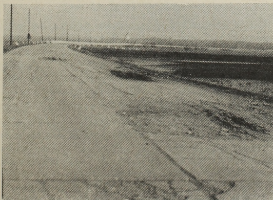
8. ábra. Az útpályael-sársódása tévégi útburkolatromlás miatt (36. sz. fkl. között, 19 km szelvény)
