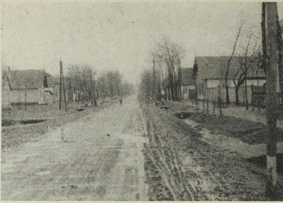
9. ábra. Sáros községi átkelési szakasz (vízzel kötött makadámurkolat)
