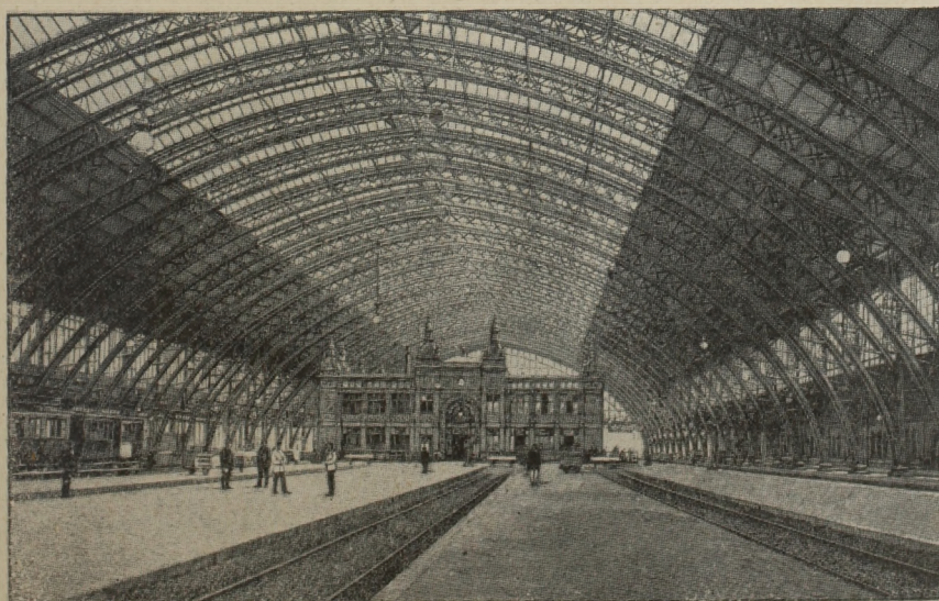
12. ábra. Köln csarnoka 1892—94 között kétesuklós ívtartóként készült
