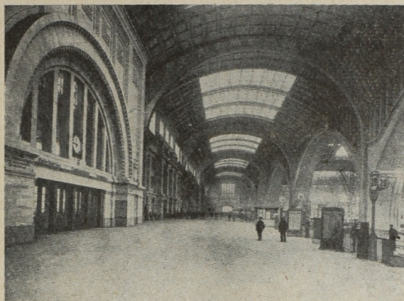
14. ábra. Lipcse. A hatalmas csarnok és a felvételi épület között 300 m hosszú keresztperon húzódik, vasbetonszerkezettel lefedve
