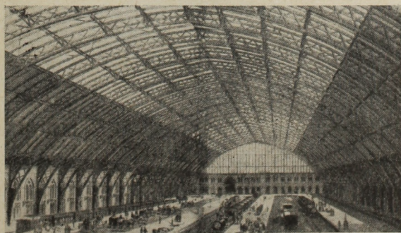
9. ábra. A londoni St. Pancras pályaudvar csarnoka 73,1 m feszítávolságával az 1870-es években nagy feltűnést keltett (1863—1876)
