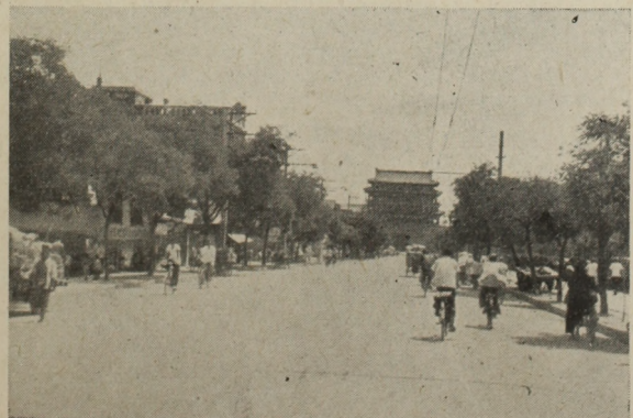
5. ábra. Új főközlekedési út Pekingben (háttérben a Hata-Men kapu). Az út négygyomú, kétoldalt jól látható a két lassú közlekedési sáv
