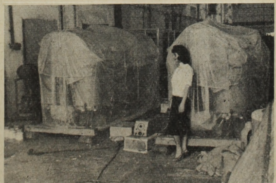
3. ábra. Légmentesen hegesztett műanyagba csomagolt villamos berendezések
