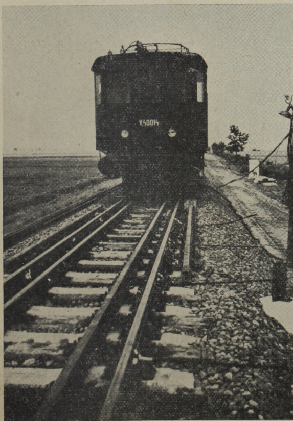
1. ábra. Az előfeszített vasbetonaljas kísérleti vágány végeinek megerősítése
