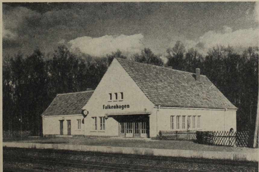
22. ábra. Falkenhagen (NDK). A táj építészet formáinak sikeres alkalmazása kisebb állomásépület esetében
