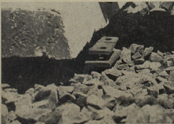
6. ábra. Görgők elhelyezése a vasbetonaljak alatt
