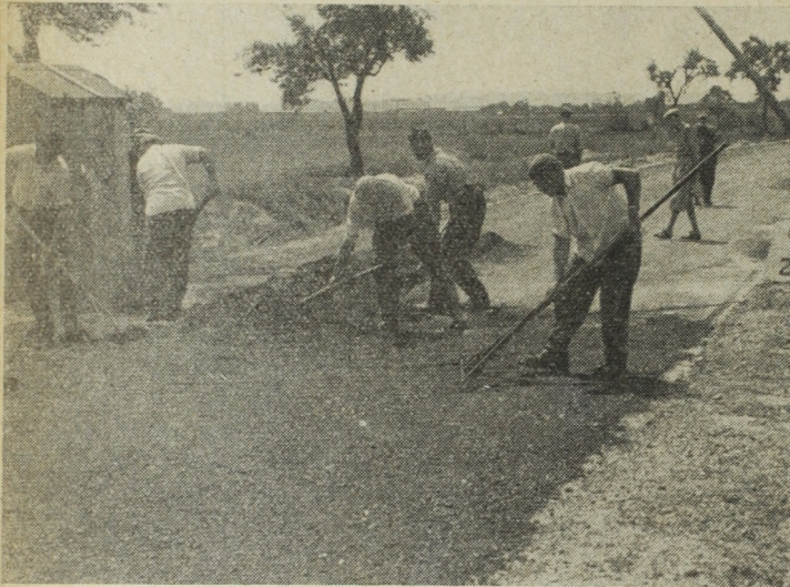
7. ábra. A Szuhakálló—ragályi összekötő út kurittyáni átkelési szakasza
