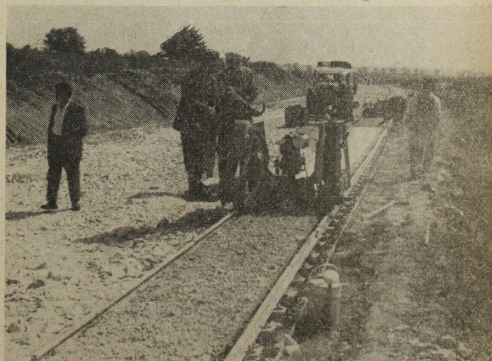
3. ábra. Fehér betonszegély építése ABG finisherrel
