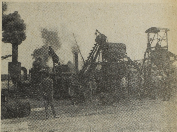
1. ábra. Az Aszfaltútépítő Vállalat bieskei aszfaltkeverőtelepe
