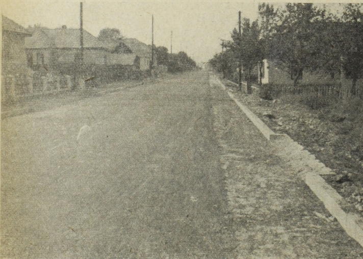
8. ábra. A Szuhakálló—ragályi összekötő út Zubogy község előtti korrekciója; az itatott aszfaltmakadám burkolat alatt meszes talajstabilizáció készült
