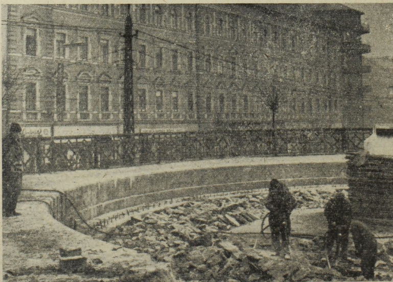
3. ábra. A fordítókorong falazatának bontása (a vasszerkezetet már elvitték) 1962. januárjában
