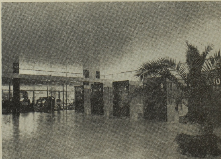
11. ábra. A pénztárcsarnok belseje. A hangszigetelő lapokkal burkolt mennyezetén, a burkoló lapok mögött nyertek elhelyezést a közönség tájékoztatására szolgáló hangtestek és a hőszigetelés
