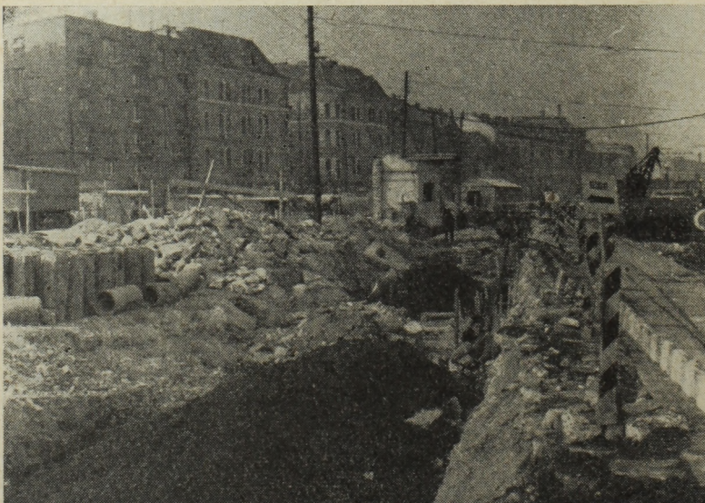
7. ábra. Vezetékek, szivárgók stb. építése
