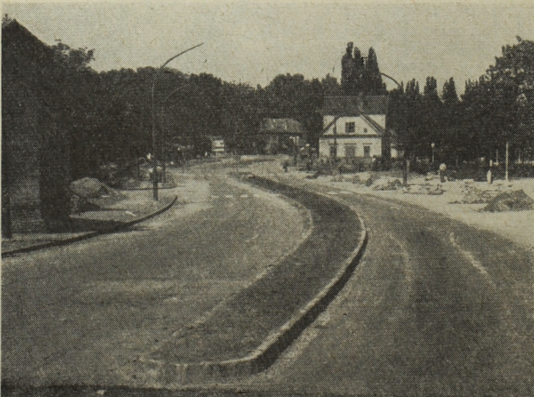
3. ábra. Korszerű elválasztó-sávcsomópontkiképzés a 7. sz. fkl. út balatonföldvári átépített szakaszán
