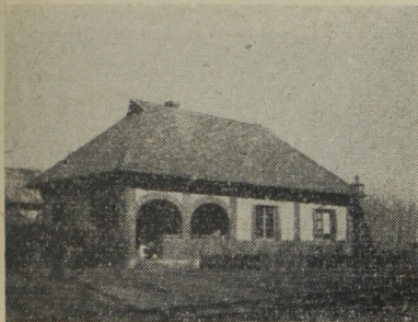
6. ábra. Acsádi út (ma Nyiracsád) állomás felvételi épülete
