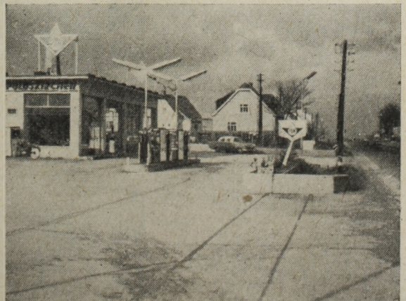
4. ábra. Kétszlopos korszerű töltőállomás a 17. sz. Wien—Trieste-i főközlekedési közút mentén (Gumpoldskirche). A megvilágítás neoncsövekkel történik. A kezelőépület három oldalán üvegtürelletű
