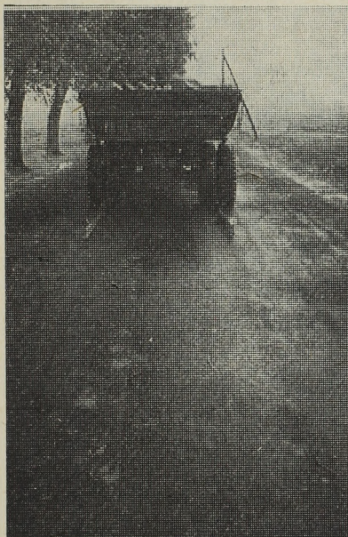
14. ábra. Behajlásmérés a III/b. számú út itatott aszfaltmakadám burkolatán.
