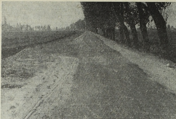
8. ábra. Az egynyomú IIIa. jelű úton utólag kitérők is épültek
