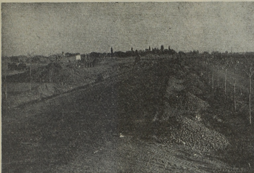
7. ábra. A bitumennel stabilizált alap az I. számú út második felén.
