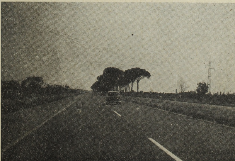
4. ábra. Az olasz autópályák leálló nyomainak burkolata azonos a főburkolattal, attól festett világos vezetésőv választja el (a Firenze—Mare autópálya egyik szakasza)
