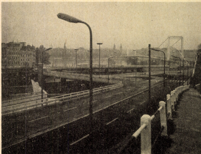
3. ábra. A budai feljáró kiképzése az elágazások miatt áthidalásokat igényelt. A hídról lehaladó gépkocsiforgalom többszáz m hosszon hídszerkezeten halad. (Domonkos E. felv.)
