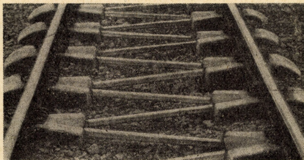
9. ábra. Holland „cik-cak” betonlaj (a sín alatti betontömböket acélrudak kötik össze)
