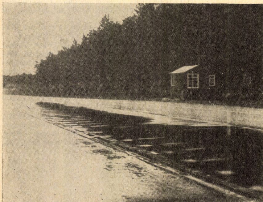
2. ábra. A kísérleti pálya különböző burkolatú, öntözhető szakasza
