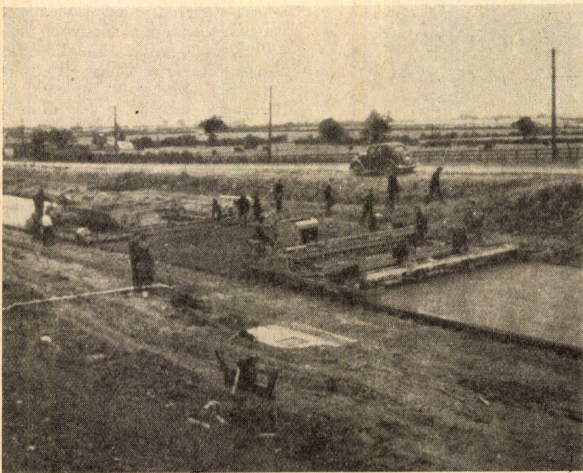
12. ábra. Összefüggő szerkezetű kísérleti útkészítés alatt. A „finisher” után közvetlenül mérik az útprofilát a szükséges javítások azonnali végrehajtása céljából
