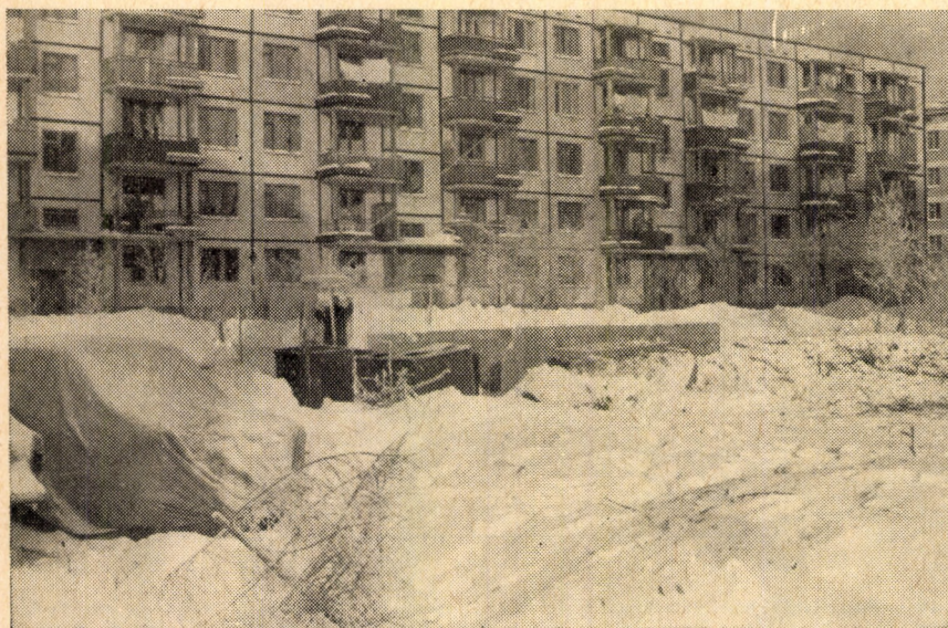
4. ábra. Novije Cserjomuski korábban épült lakóházaik között még csak kevés parkolóhely épült, a járműveket ezeken tárolják, a szeméttárolás szomszédságában
