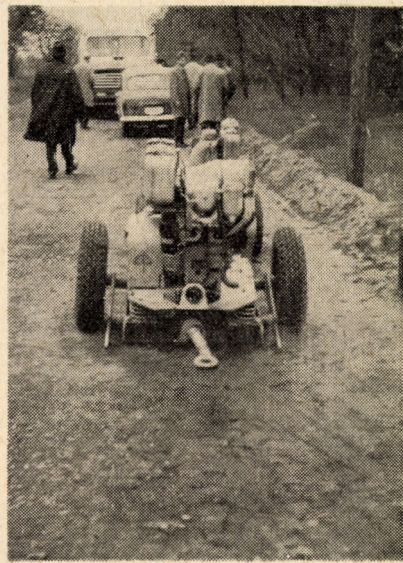
9. ábra. A 422. sz. főközlekedési közúton hígított bitumenes talajstabilizálással készített burkolatalap-szélesítés és a tömörítéshez felhasznált nehéz lapvibrátor
