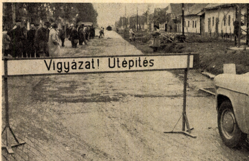
13. ábra. A Hódmezővásárhelyi—baksi út bitumennel stabilizált finom homok-alapú itatott aszfaltmakadám-burkolatának agyagos bitumenszuspenzió és homok keverékéből készített habarccsal való lezárása
