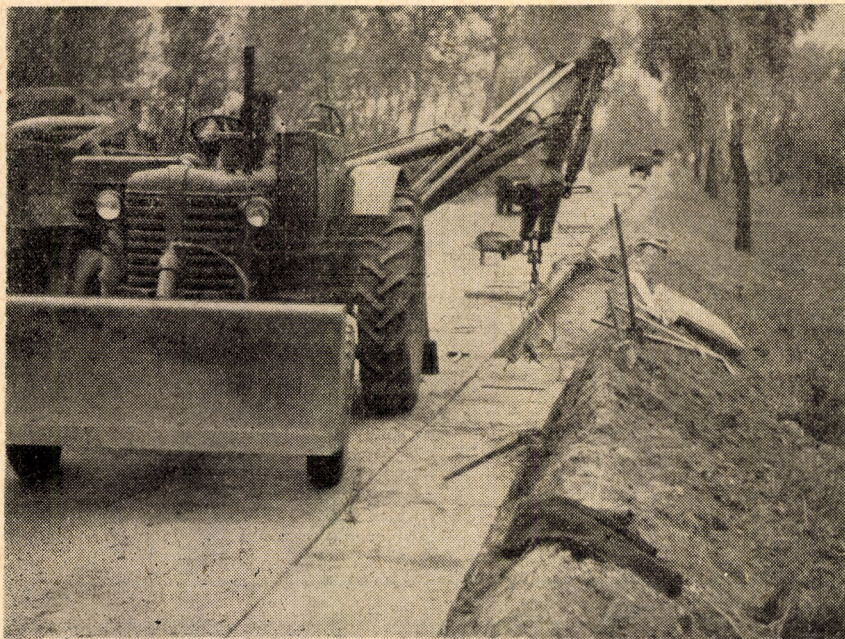
5. ábra. A betonburkolat betonlapokkal való szélesítése
