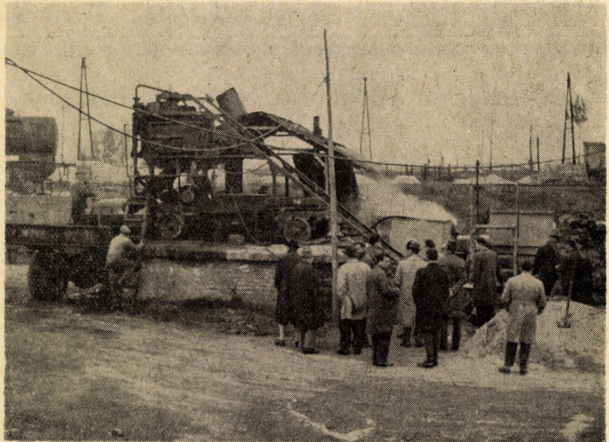
14. ábra. A Hódmezővásárhelyi Közüti Üzem Vállalat agyagos bitumenszuspenzió és homokos habares előállítására szolgáló keverőtelepe
