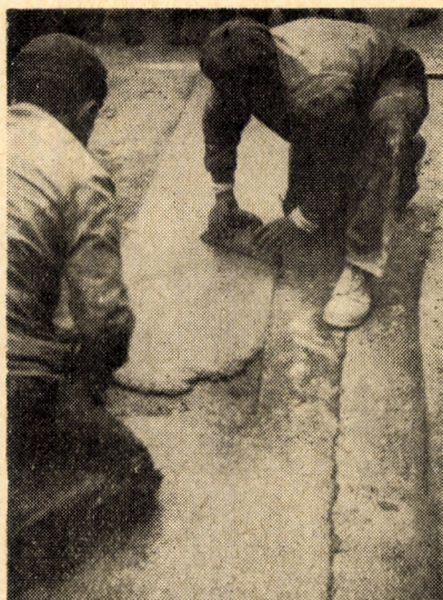
11. ábra. Színes aszfalt burkolatjelzőként való beépítése
