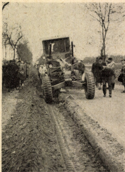
8. ábra. A 422. sz. főközlekedési közúton a keskeny kőpálya szélesítési tükrének átalakított útgyaluval való kiemlése
