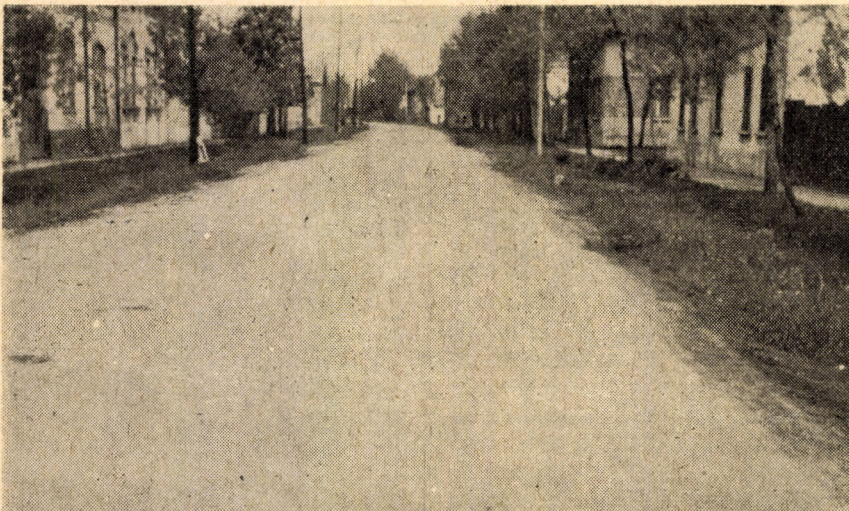
12. ábra. A Hódmezővásárhelyi Damjanich utca agyagos bitumenszuspenzió felhasználásával 1960-ban készített kísérleti burkolata
