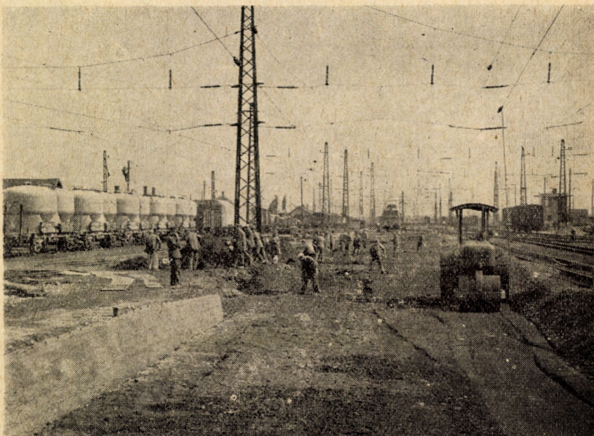
4. ábra. A vágányok alatti talajjavító réteg készítése
