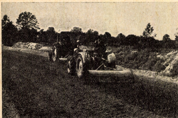
6. ábra. Az UNIMOG-talajmaró 15 cm laza vastagságig eredményesen végzi a szemcsés és kötött talajok összekeverését
