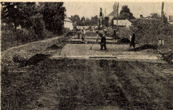
8. ábra. A javított útpálya kellő oldalesését és egyenletességét profilpallóval ellenőrizzük
