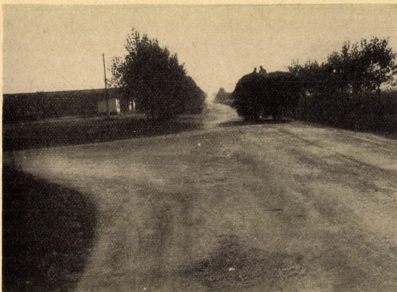
3. ábra. Kétnyomú bekötőút az Izsáki Állami Gazdaság Balázs-tanyai üzemegységében. Az itatott aszfaltmakadám-burkolat hígított bitumennel stabilizált finom homok-alapra épült
