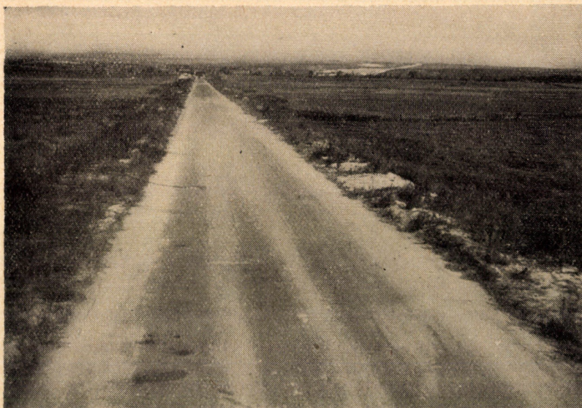
4. ábra. A Balázs-tanyai egynyomú főgyűjtő úton a stabilizált alapra fektetett kevert aszfalt-szőnyeg a forgalom alatti kedvezően viselkedik
