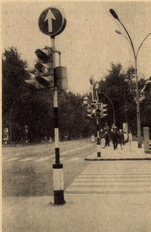
8. ábra. Licencia alapján Magyarországon gyártott Tesla-rendszerű berendezés jelzőoszlopa
