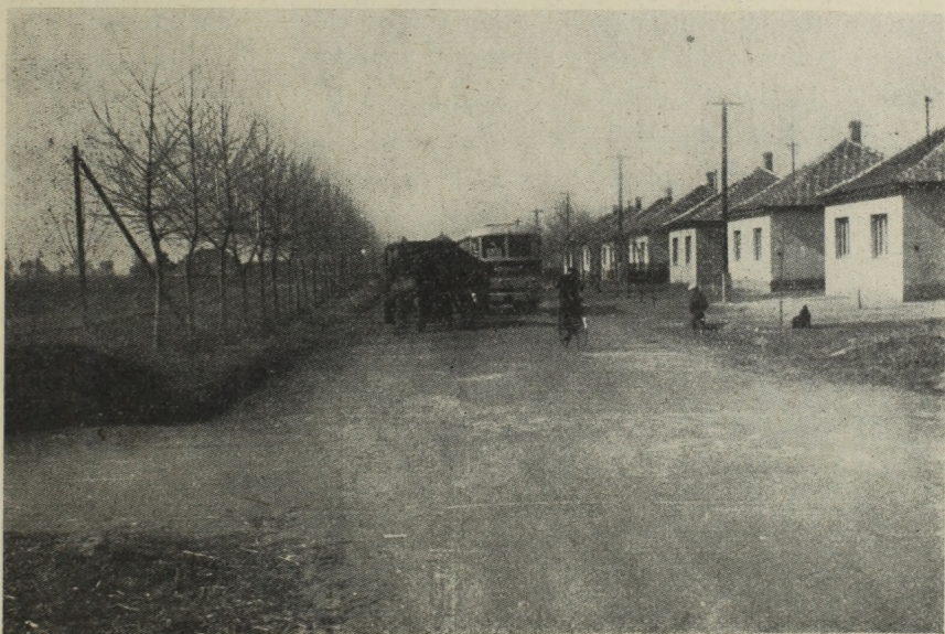
2. ábra. Az Izsáki Állami Gazdaság Balázs-tanyai üzemegységének 1963-ban épült kétnyomú bekötőútja. A pályaszerkezet bitumennel stabilizált alapon itatott aszfaltmakadám-burkolat. Az előtérben betonba rakott terméskő-sáv, a keresztező földúton közlekedő hernyótalpas traktorok forgalma miatt
