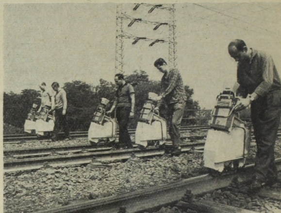
5. ábra. Ultrahangos sínvizsgáló készülékek munkaközben
