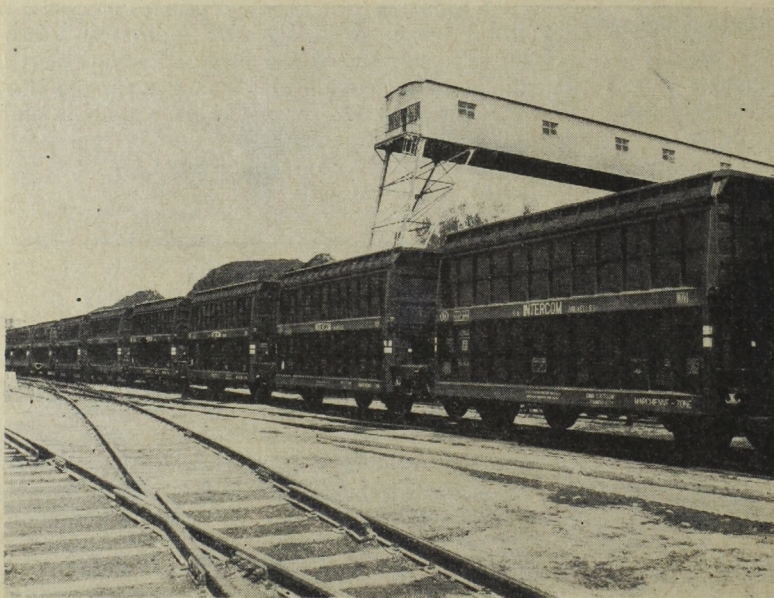
1. ábra. INTERCOM kocsikból álló szénszállító vonat a Ruleni villamos erőmű fogadó vágányain. A vonatok ingajáratban közlekednek a bánya és a villamos erőmű között
