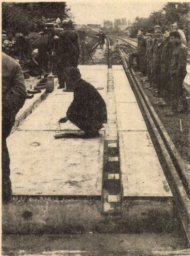
2. ábra. Nagylemeses útátjáró fektetése
