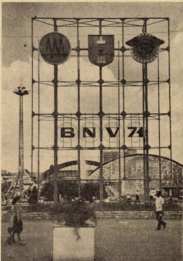
1. ábra. A vásár főterén emelt impozáns fogadó fal, felső részén a BNV-emblémával, a Főváros címerével és a Nemzetközi Vásárok Szövetségének jelvényével. Háttérben a magyar alumíniumipar hatalmas kiállító-csarnoka újszerű, ötletes faldíszítésével vonja magára a látogató figyelmét
