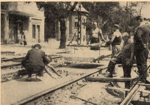
8. ábra. A betonelemek elhelyezése
