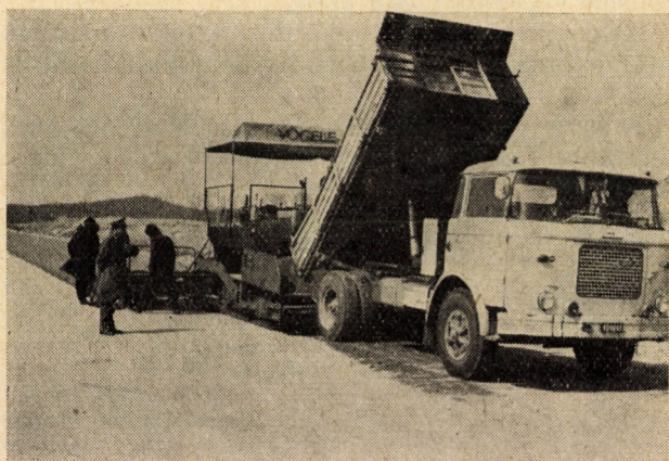
4. ábra. Cementstabilizáció készítése Vögele Super 200-as finiserrel az M7 autópálya építésénél
