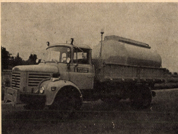
7. ábra. 5 m 3 -es víztartály öntözéshez, Berliet GLR 160 tehergépkocsira szerelve
