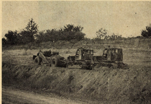
2. ábra. Durvatükör vágása Pull-szkréperrel az M7 autópálya építésénél
