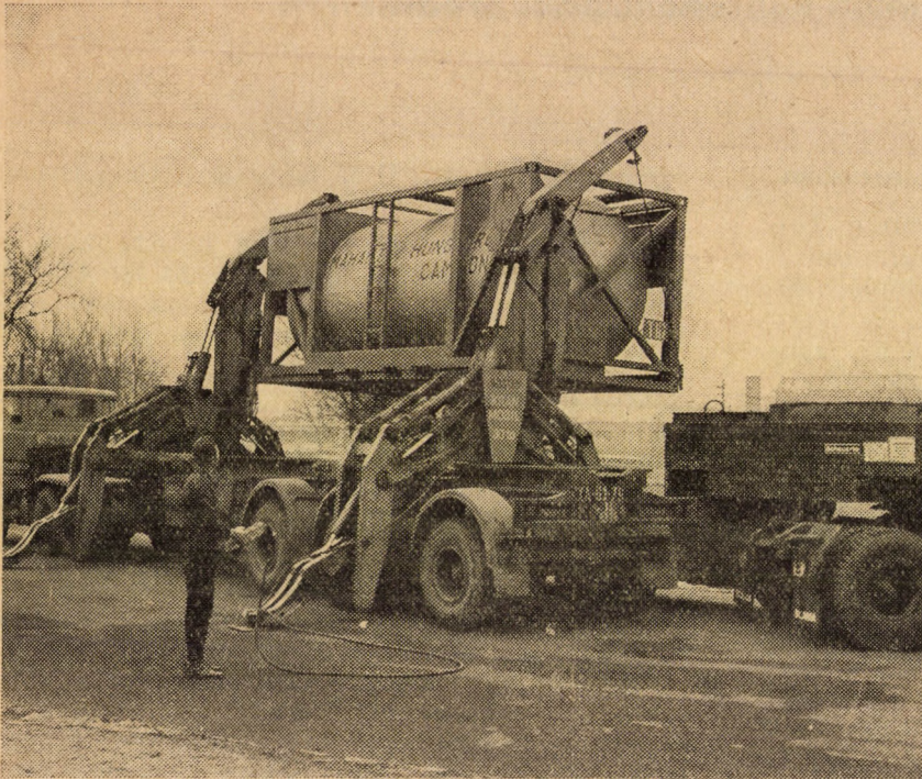
1. ábra. Klaus-Krammobil típusú berendezés nagy konténerek átrakásához
