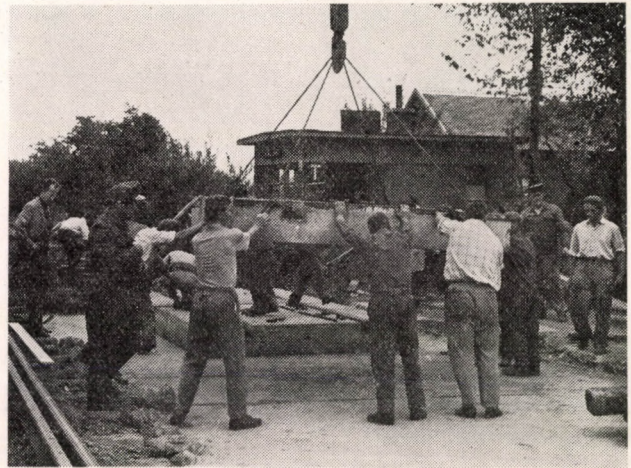
5. ábra. Osztatlan nagylemezes elem gépi elhelyezése
