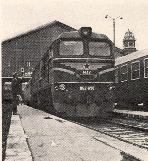
6. ábra. 2000 LE teljesítményű szovjet gyártmányú Diesel-mozdony a MÁV üzemében
