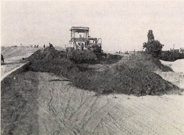
6. ábra. Földmunkák a 4. sz. főút építésénél
