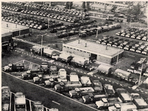
1. ábra. Korszerű gépkocsi-tárolóhely és a kapcsolódó létesítmények Budapesten, a Mogyoródi úton
